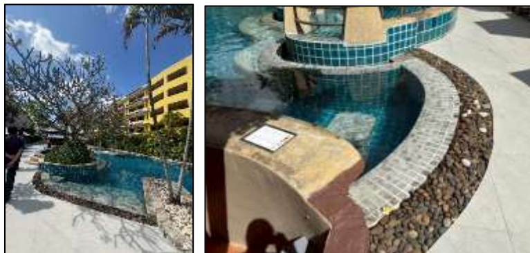
รูปที่ 3-36 รางระบายน้ำล้นมีฝาปิดรอบสระน้ำ ภายในโรงแรม
